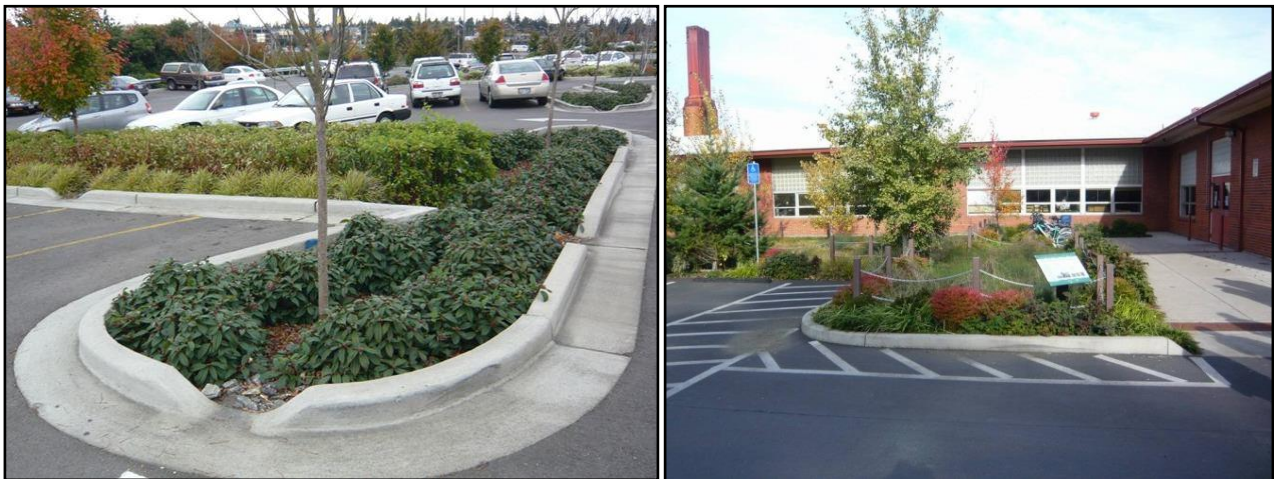
Kuva 4. Pysäköintialueen ja rakennuksen läheisyydessä olevat viherpainanteet.
