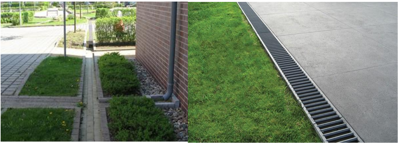
Kuva 3. Hulevesien johtaminen pinnalla avonaisilla kouruilla ja linjakuivatuskouruilla 6 .
